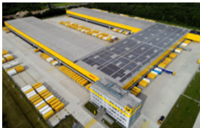
DHL Mega-Paketzentrums Obertshausen Quelle: DHL
