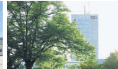
Hochhaus vor der Sanierung
